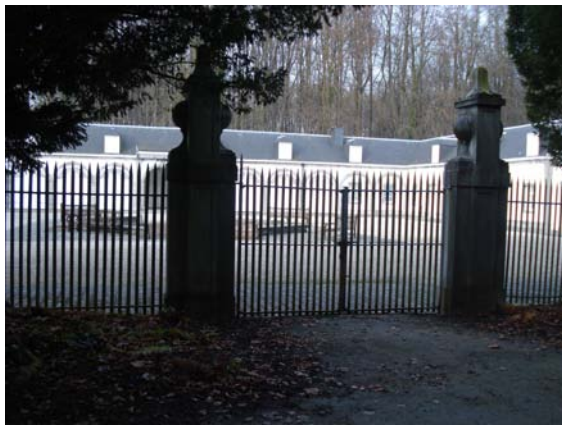
Photo 11 : Grille d'accès à une cour secondaire (difficilement praticable)
