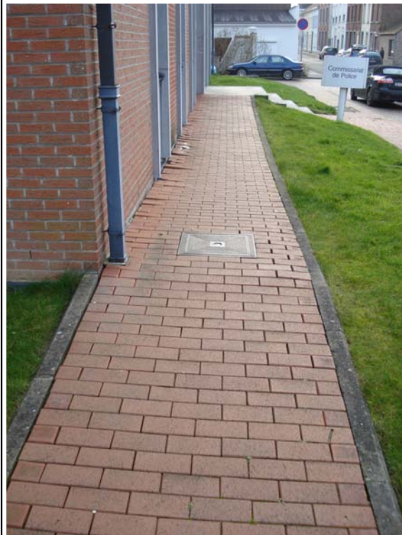
Photo 3 : Libre passage inférieur à 150cm
