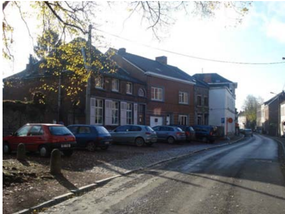
Photo 1 : Traversée non sécurisée
