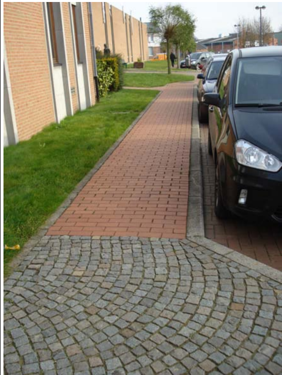
Photo 10 : Libre passage inférieur à 150cm
