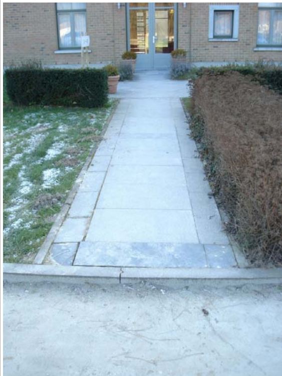
Photo 3 : Pas d'inflexion de bordure du parking vers les appartements
