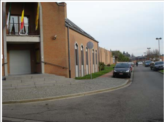
Photo 2 : Vue d'ensemble du cheminement
