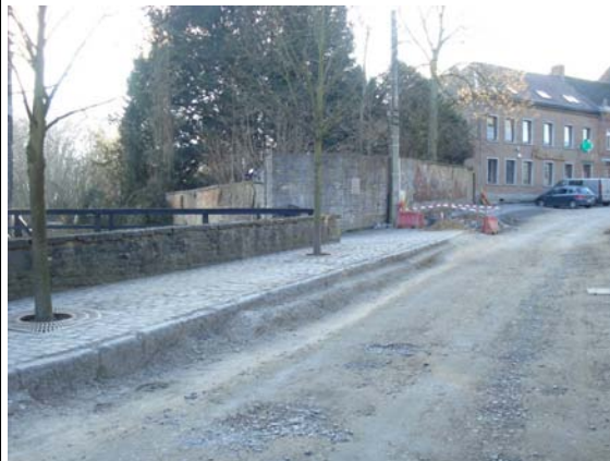
Photo 4 : Difficile de juger la traversée et les inflexions de bordure avec l'ensemble du centre ville en travaux mais rien n'a l'air prévu.
