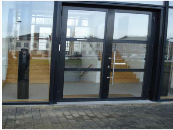
Photo 14 : Seuil difficilement franchissable
