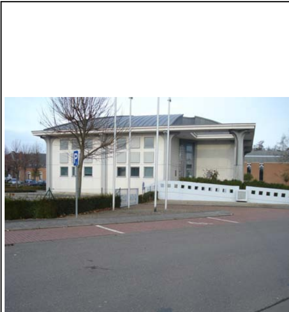
Photo 1 : Vue générale du bâtiment
