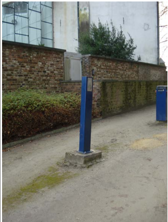
Photo 2 : Parlophone permettant de demander l'ouverture de la barrière (le son va suffisamment fort pour les personnes malentendantes)
