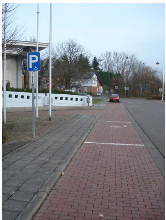
Photo 2 : Emplacement réservé mais pas aux normes
