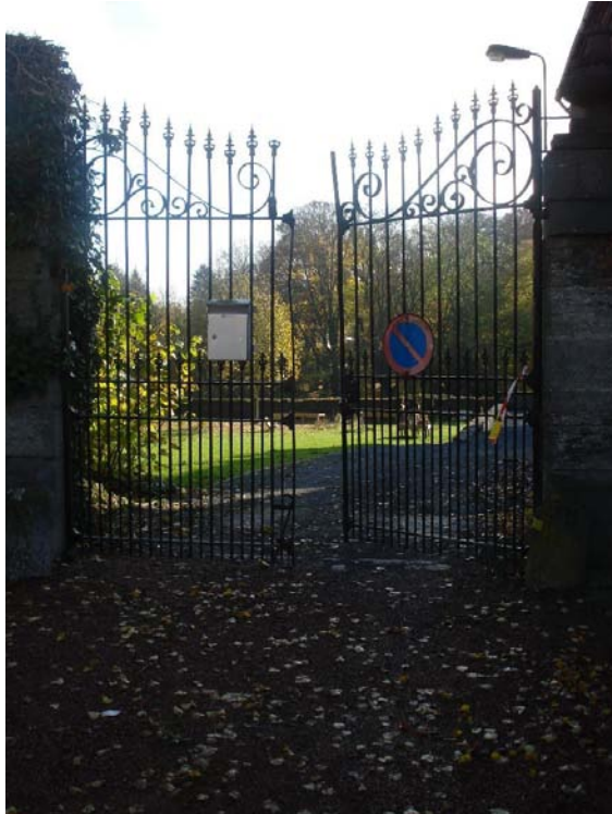
Photo 5 : Pas de sonnette installée, boîte aux lettres trop haute
