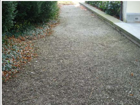
Photo 14 : Graviers du cheminement principal difficilement praticables
