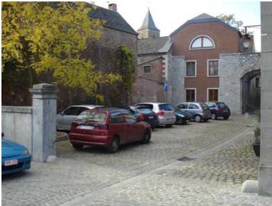
Photo 3 : Filet d'eau relativement plat mais avaloir non signalé (risque pour les personnes malvoyantes)
