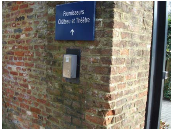
Photo 5 : Parlophone pour l'ouverture de la grille
