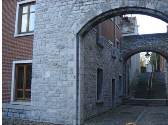
Photo 6 : Filet d'eau, avaloir, seuil trop haut pour entrer dans l'habitation
