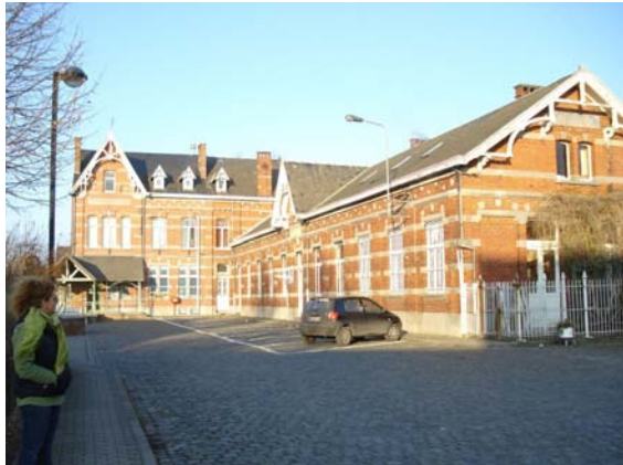
Photo 1 : Vue générale du site
