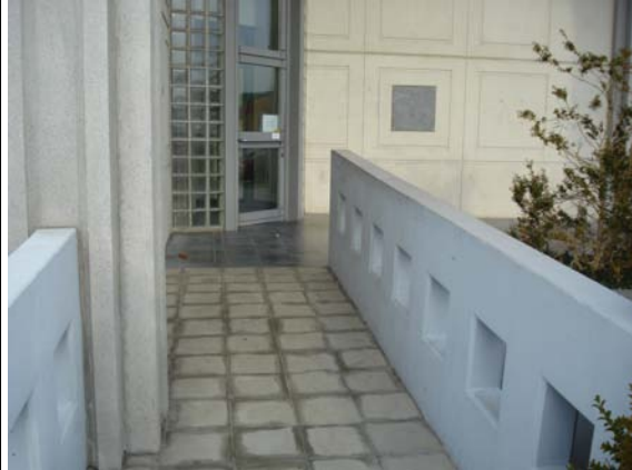
Photo 6 ; Pente d'accès aménagée aux normes
