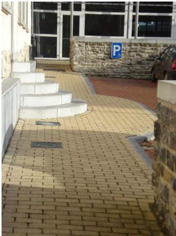
Photo 9 : Cheminement PMR correct mais éclairage au sol aveuglant
