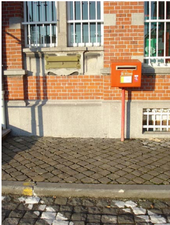
Photo 7 : Boîte aux lettres inaccessible et dangereuse
