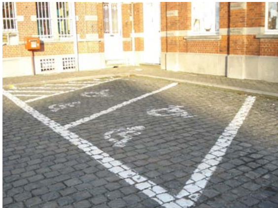
Photo 3 : Emplacements PMR de mauvaises dimensions et mal indiqués (pas de panneau de signalisation). De plus, le sol qui entoure les emplacements est impraticable pour une personne en fauteuil roulant.
