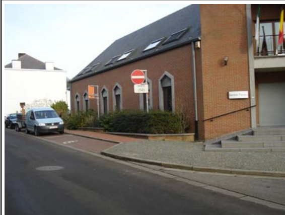
Photo 1 : Vue d'ensemble du cheminement
