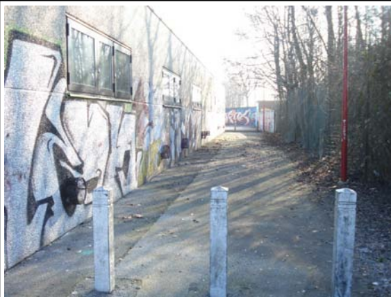
Photo 11 : Piquets rendant difficile l'accès latéral de la salle
