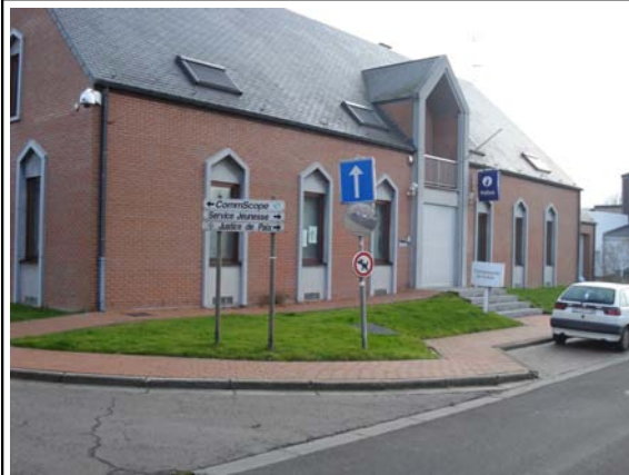
Photo 1 : Vue d'ensemble du cheminement et du bâtiment
