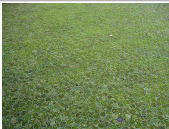
Photo 8 "Revêtement" du parking
