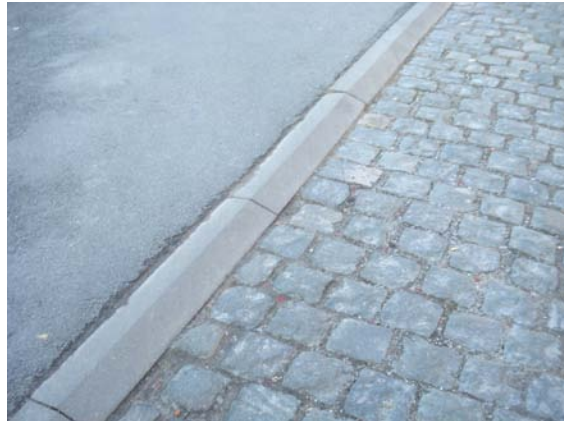
Photo 2 : Pavés impraticables, pas d'inflexion de bordure et aucune traversée sécurisée.
