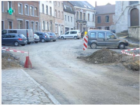
Photo 7 : Centre ville en travaux
