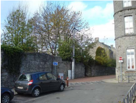
Photo 1 : Chaussée sécurisée pour les piétons
