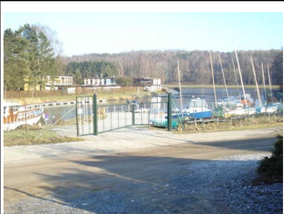
Photo 2 : Vue du port, revêtement non stabilisé
