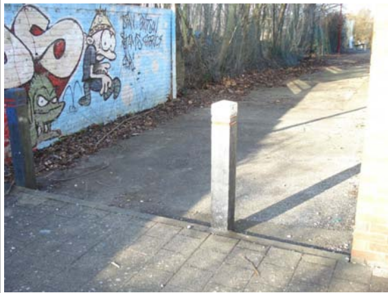
Photo 15 : Le piquet manque de contraste et la marche est dans le cheminement
