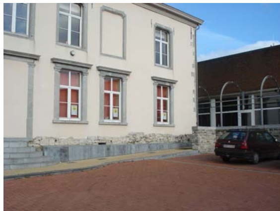
Photo 6 : Cheminement PMR dans les normes
