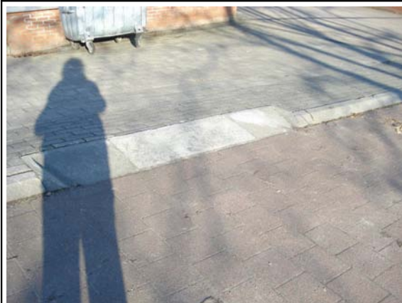
Photo 1 : Pente trop raide pour permettre le passage.
