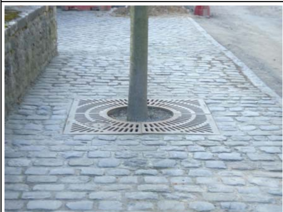
Photo 5 : Protection efficace contre un obstacle
