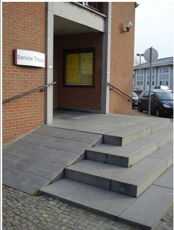
Photo 4 : Pente aménagée aux normes
