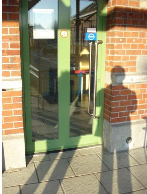
Photo 6 : Porte d'entrée aux normes
